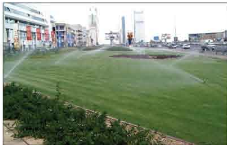
Las válvulas reguladas a presión Accu-Set™ usadas por el ayuntamiento de Dubai, EAU, permiten que las turbinas funcionen a una presión óptima para una distribución eficaz del agua.
