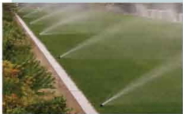
Turbinas Hunter PGJ en funcionamiento en el San Diego Convention Center, San Diego, California, EEUU.
